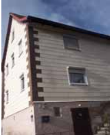
Abb. 11 Gebäude der jüdischen Schule in der Oststraße 9 heute
